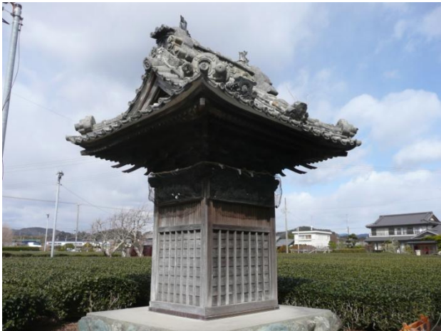
龍燈 修理前 全景
