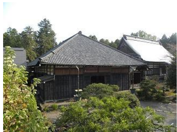
大庫裏着工前(右奥:客殿)
