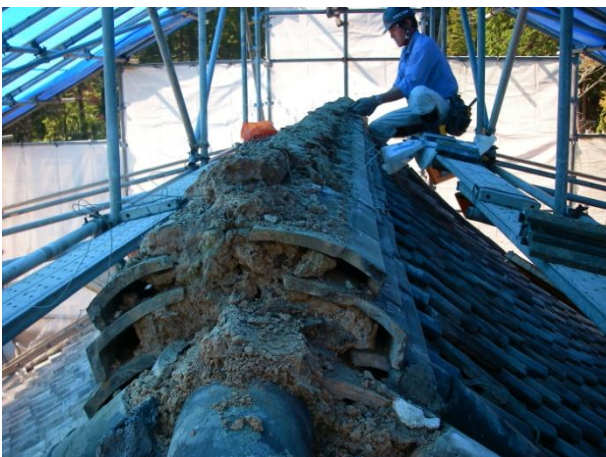
天徳寺山門 棟解体状況
