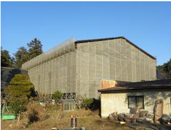
素屋根仮設足場全景
