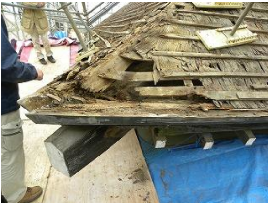
北東隅腐朽部分の様子
