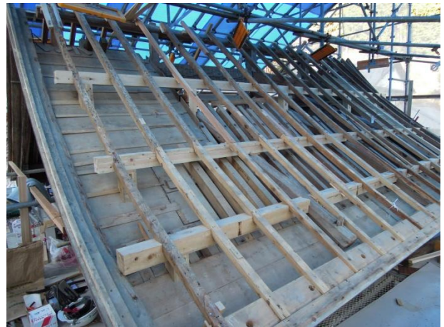
天徳寺山門 母屋取替状況
