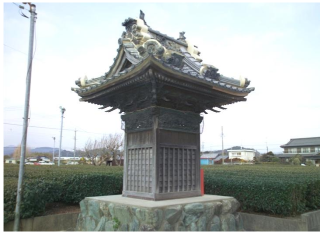
龍燈 竣工 全景
