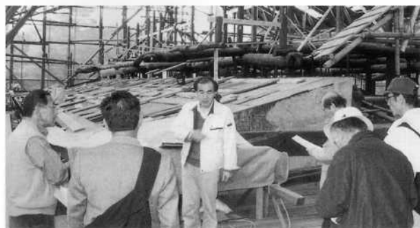
玉林院本堂修理現場見学会
