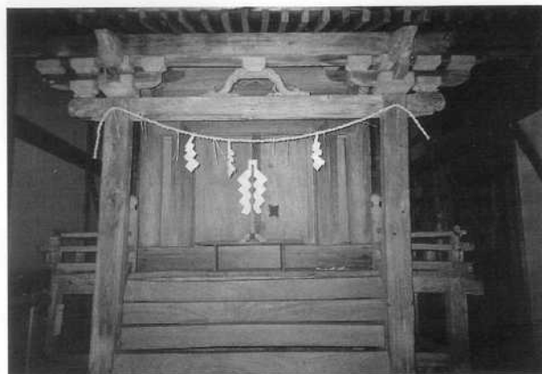
熱田神社本殿 正面
