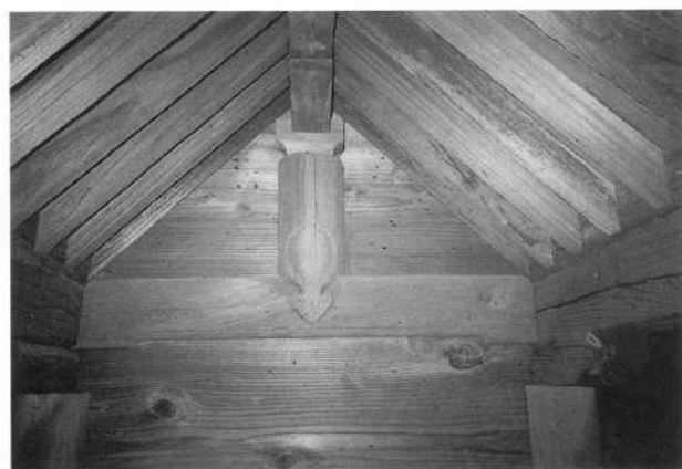
八幡神社本殿 妻面細部
