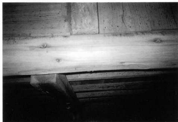
八幡神社本殿 向拝柱脚ひかり付
